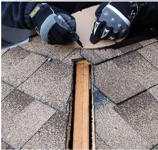
**ÉTAPE 2** – Pivotez le gabarit sur le plan du toit avant. Alignez le premier angle à l'arêtier gauche. Marquez un deuxième angle sur le gabarit pour l'arêtier droit. Utilisez une règle pour tirer une ligne de cette deuxième marque à l'entaille du gabarit.
