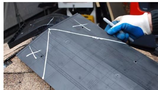
**ÉTAPE 5** – Coupez l'Évent d'Arêtier Cobra<sup>MD</sup> soigneusement le long des deux lignes. La section de l'évent d'arêtier droit est maintenant achevée.
