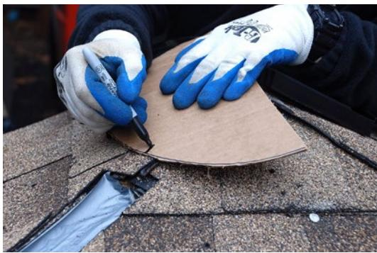
**PASO 7 –** Gire la plantilla al plano del techo del frente. Alinee el primer ángulo con el lado inclinado derecho. Marque un segundo ángulo sobre la plantilla para el lado inclinado izquierdo. Utilice una regla para trazar una línea que conecte la segunda marca a la muesca de la plantilla.
