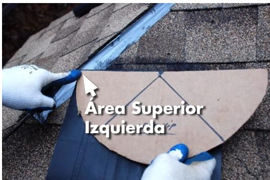
**PASO 9 –** Ubique el centro superior de la Ventilación Cobra® para Techos a Cuatro Aguas. Utilice una regla para dibujar dos líneas desde el **área superior central** a través de los dos ángulos marcados previamente. Corte con cuidado la ventilación a lo largo de las dos líneas como se muestra en el **Paso 5**. La sección izquierda de la ventilación para techos a cuatro aguas ahora está completa.
