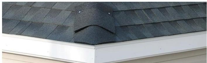
**Comenzar por la parte inferior del techo a cuatro aguas más cercana al alero:** Centre y ajuste la Ventilación Cobra® para Techos a Cuatro Aguas sobre las tejas, apoyándola firme contra la superficie del techo.
