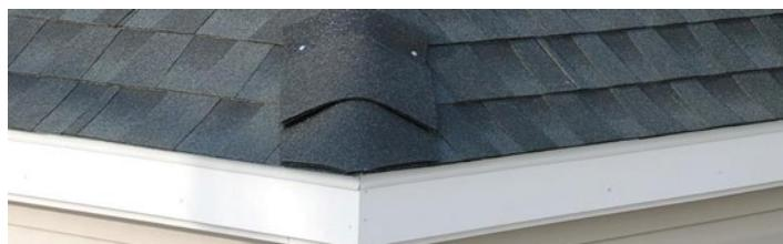
**Commencant à la base de l'arêtier le plus près de l'avant-toit :** Centrez et formez l'Évent d'Arêtier Cobra<sup>MD</sup> par-dessus les bardeaux, le plaçant solidement sur la surface du toit.
