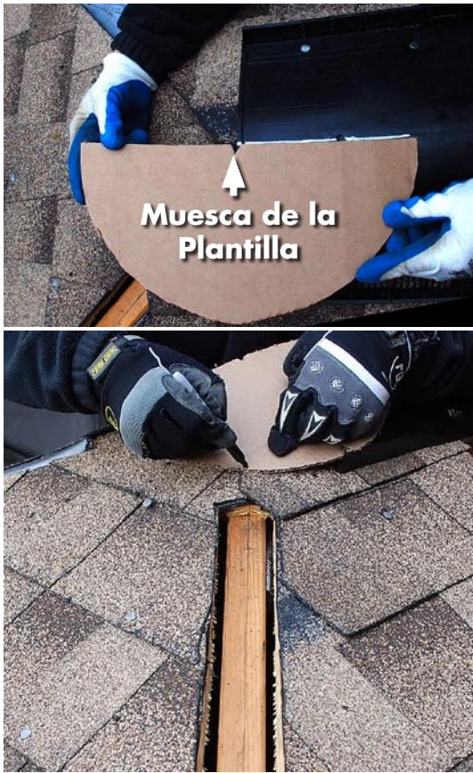
**PASO 2** — Gire la plantilla al plano del techo del frente. Alinee el primer ángulo con el lado inclinado izquierdo. Marque un segundo ángulo sobre la plantilla para el lado inclinado derecho. Utilice una regla para trazar una línea que conecte la segunda marca a la muesca de la plantilla.
