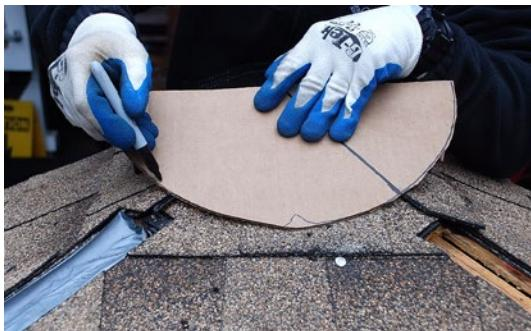
**PASO 8 –** Alinee la plantilla a la **esquina superior izquierda** de la Ventilación Cobra® para Techos a Cuatro Aguas y marque los dos ángulos en la parte superior de la ventilación.
