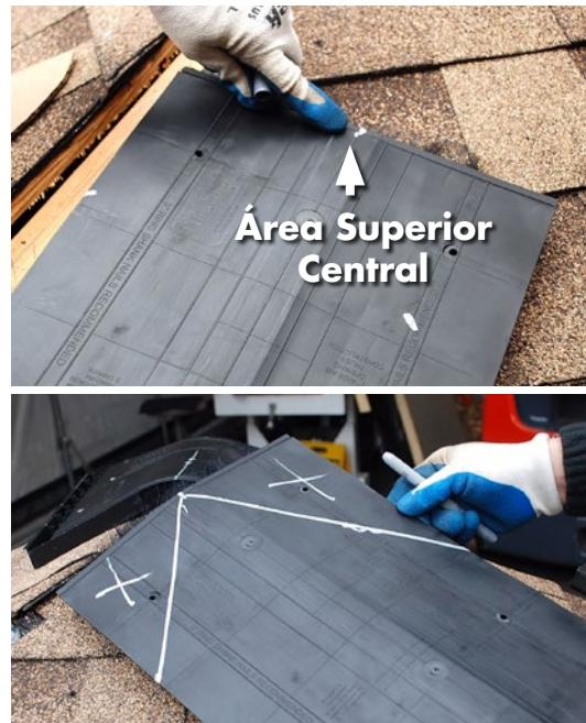
**PASO 5** — Corte con cuidado la Ventilación Cobra® para Techos a Cuatro Aguas a lo largo de las dos líneas. La sección derecha de la ventilación para techos a cuatro aguas ahora está completa.
