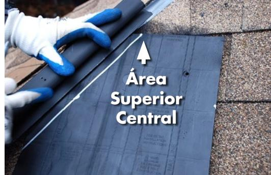
**PASO 10 –** Una las Ventilaciones Cobra® para Techos a Cuatro Aguas con la ventilación de borde. Ajuste las ventilaciones para techos a cuatro aguas con clavos helicoidales de 1 3/4" (44 mm) a través de los orificios premarcados de 6" (152 mm) de la pistola de clavos. Utilice una cinta ancha de 3" (76 mm) WeatherWatch® o la barrera contra goteras autoadhesiva StormGuard® para cubrir posibles uniones entre ventilaciones.
