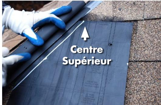
**ÉTAPE 10 —** Ajustez bien les évents d'arêtier Cobra<sup>MD</sup> ensemble et à l'évent de faîtiage. Fixez les évents d'arêtier en place utilisant des clous de clouseuse à rouleau pneumatique de 44 mm à travers les cibles de clouseuse prémarquées à 152 mm d'intervalle. Utilisez une bande de 76 mm de large de la membrane d'étanchéité auto adhésive WeatherWatch<sup>MD</sup> ou StormGuard<sup>MD</sup> pour couvrir tout joint entre les évents.
