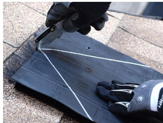
**PASO 6 –** Voltee la plantilla y utilicela para encontrar los ángulos para el lado inclinado izquierdo. Marque el primer ángulo para el lado inclinado izquierdo sobre la plantilla. Utilice una regla para trazar una línea que conecte esta marca a **la muesca de la plantilla**.
